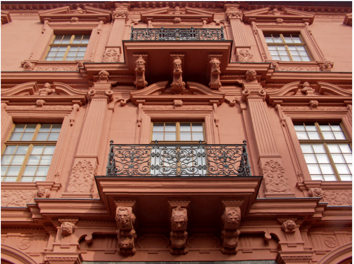
Das Kurfürstliche Schloss wird schrittweise saniert.
